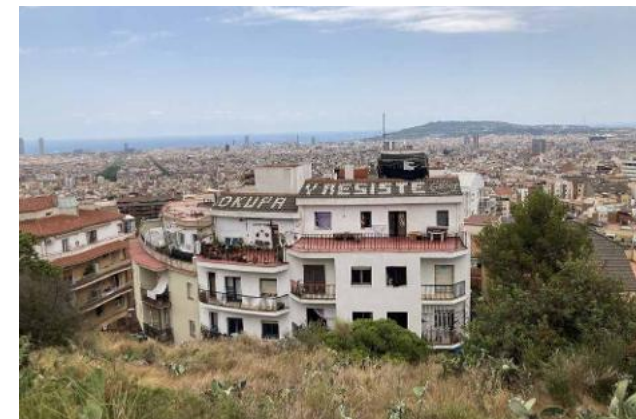
© Mattsjc, Wikimedia Commons (CC BY 4.0) The slogan 'occupy and resist', as seen here painted on a Barcelona roof, comes from the Spanish anti-capitalist 'Okupa' movement. // Der Slogan „Besetze und leiste Widerstand“, wie hier auf einem Dach in Barcelona, stammt von der spanischen kapitalismuskritischen Okupa-Bewegung.
